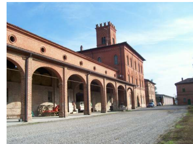
Vista di portici e di casa padronale in una grande cascina agricola
